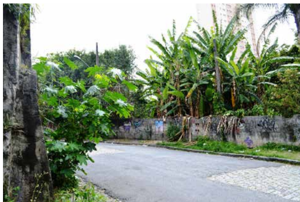
Calçadas recobertas por toda a sorte de plantas rústicas em via local do bairro de Santana.
